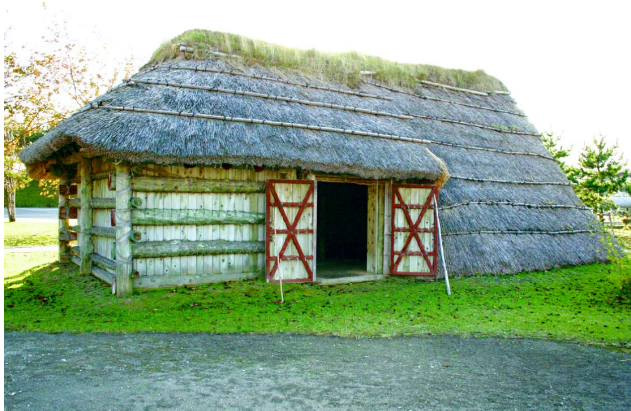
「発茶沢遺跡」から発掘された平安時代中期の住居跡を復元した建物。竪穴の竈の外側に掘っ立て柱建造物跡が接続しているのが特徴。右側の竪穴部分が住居部分。掘っ立て柱部分は馬小屋などに使用されたと思われる ＝六ヶ所村立郷土館
